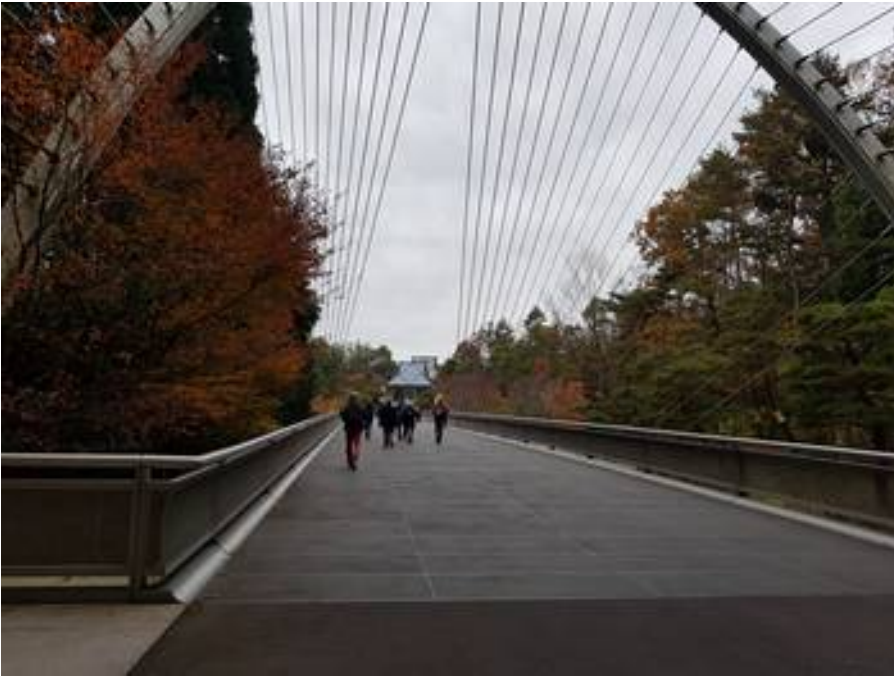
Die Brücke nach dem Tunnel des Miho Museum
